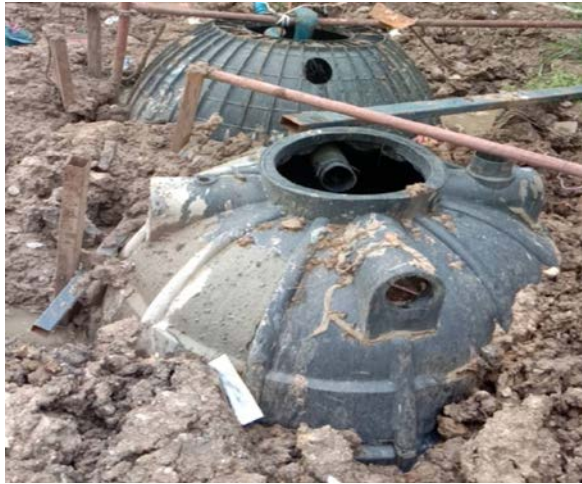
รูปที่ 2.25 ถังบำบัดน้ำเสียสำเร็จรูป (ถังแซท)
