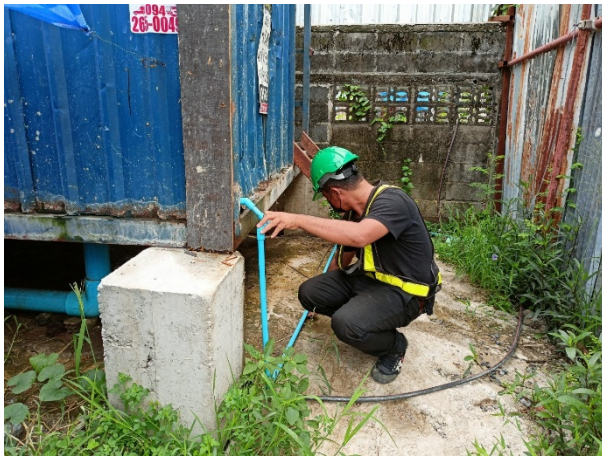
รูปที่ 2.27 เจ้าหน้าที่ตรวจสอบการรั่วซึมของห้องน้ำ
