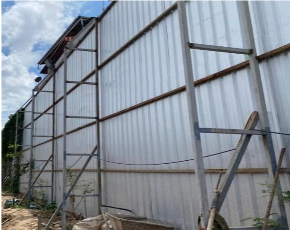
รูปที่ 2.1 ร้ว Metal -Sheet ความสูงไม่น้อยกว่า 6 เมตร
