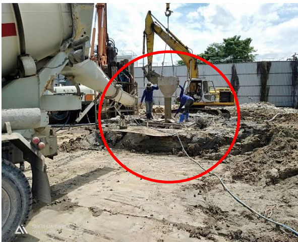
รูปที่ 2.9 ร่องชั่วคราวบริเวณหลุมเจาะเสาเข็ม
