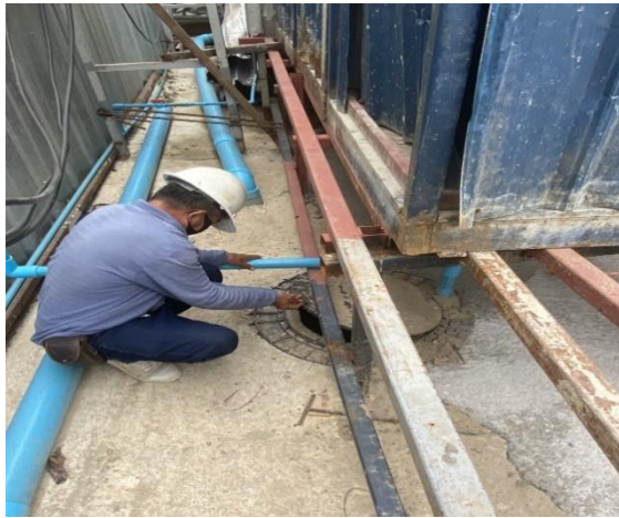
รูปที่ 2.51 เจ้าหน้าที่ตรวจสอบสภาพถังบำบัดน้ำเสีย (ถังแซท)
