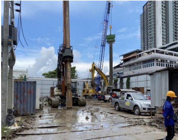
รูปที่ 2.54 การใช้เสาเข็มเจาะ
