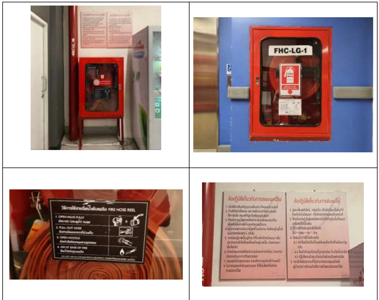
รูปที่ 2.19 ตู้ FHC พร้อมป้ายแนะนำการใช้งาน
