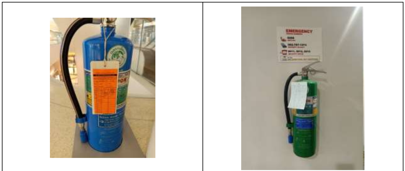
รูปที่ 2.21 การตรวจสอบถังดับเพลิง
