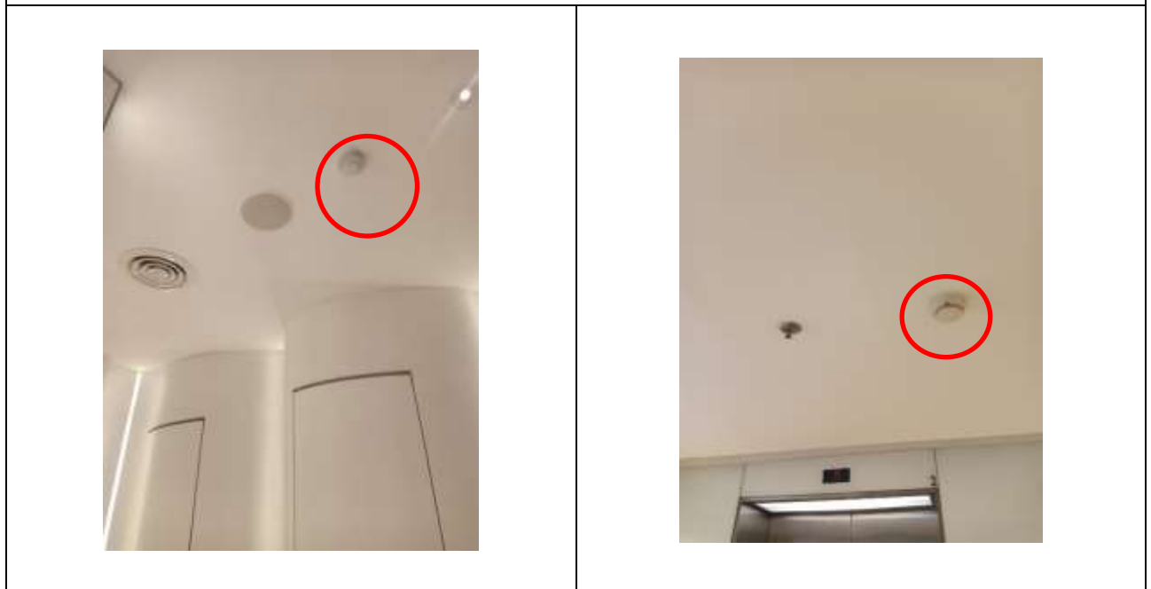
รูปที่ 2.25 เครื่องตรวจจับความร้อน
