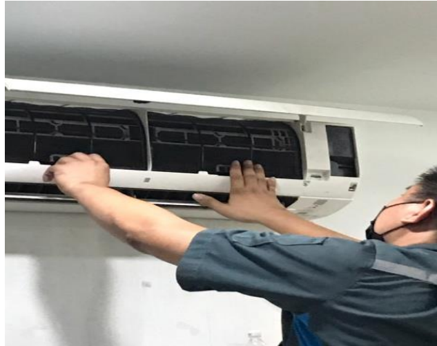
รูปที่ 32 ภาพล้างเครื่องปรับอากาศ
