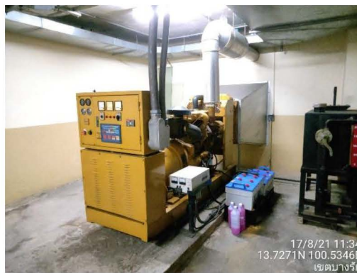
ภาพที่ 2-10 เครื่องกำเนิดไฟฟ้าสำรองในห้องเครื่องชั้นใต้ดิน
