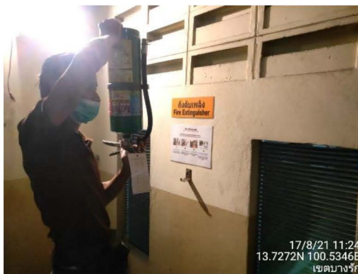
ภาพที่ 2-5 เจ้าหน้าที่ตรวจสอบถังดับเพลิงเคมี
