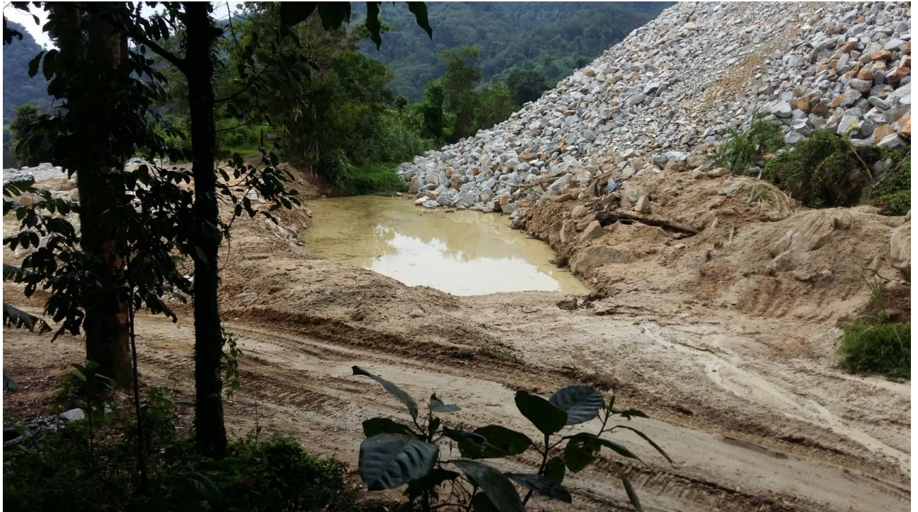
รูปที่ 8 บ่อดักตะกอนที่ต่อจากที่กองเศษดินและหินจากหน้าเหมืองหลวงปู่จี (ทิศตะวันตกเฉียงใต้)
