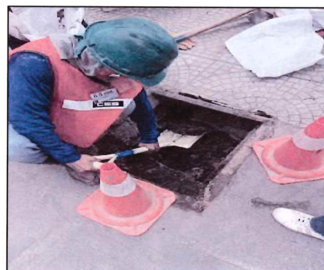
รูปที่ 1-4 การทำความสะอาดบ่อดักน้ำชั่วคราวและบ่อดักตะกอนดิน
