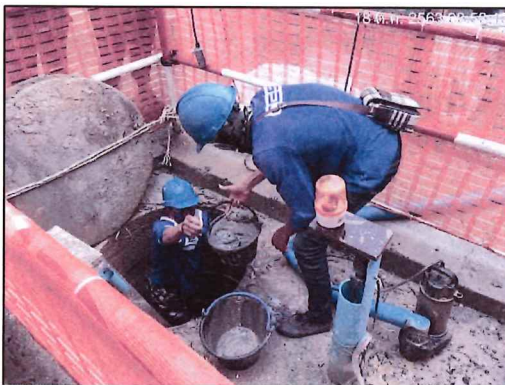
รูปที่ 1-4 การทำความสะอาดบ่อดักน้ำชั่วคราวและบ่อดักตะกอนดิน
