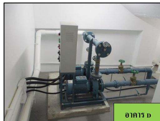
รูปที่ 1-5 ปัมป์ตักเก็บน้ำชั้นใต้ดิน
