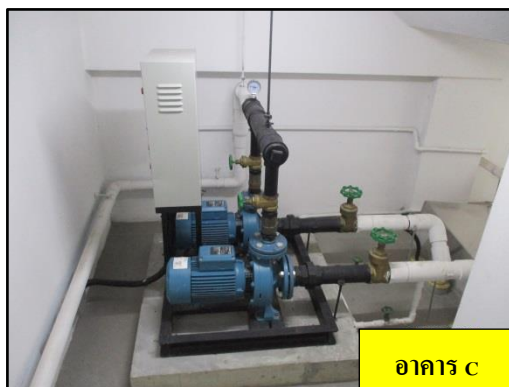
รูปที่ 1-5 ปัมป์ตักเก็บน้ำชั้นใต้ดิน
