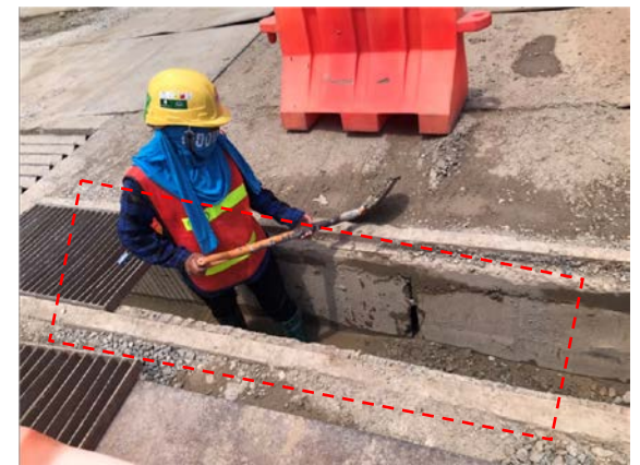
รูปที่ 2-7 รางระบายน้ำรอบพื้นที่ก่อสร้าง
