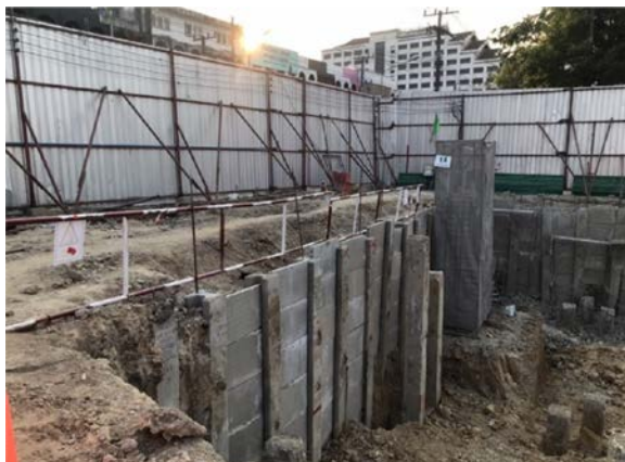
รูปที่ 2-6 Pile Wall
