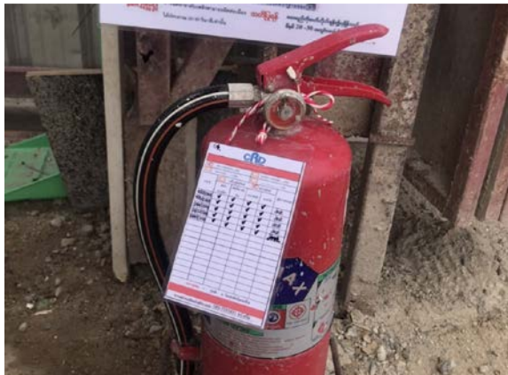
รูปที่ 2-56 การตรวจสอบถังดับเพลิง
