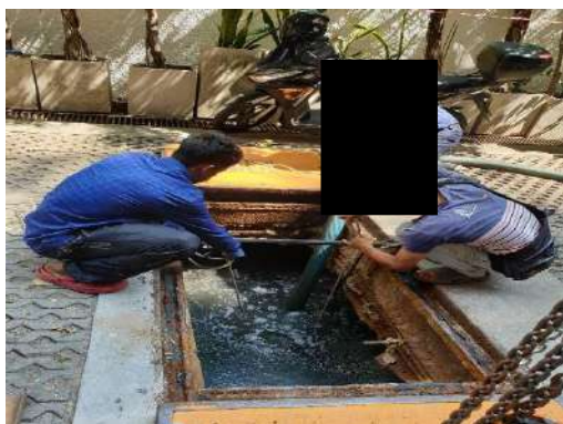
รูปที่ 2-22 (ต่อ) ทำความสะอาดระบบบำบัดน้ำเสีย
