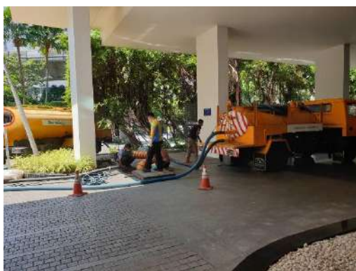
รูปที่ 2-12 การสูบกากตะกอนโครงการ
