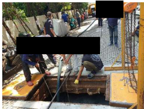
รูปที่ 2-22 (ต่อ) ทำความสะอาดระบบบำบัดน้ำเสีย
