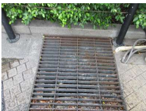
รูปที่ 2-23 ตะแกรงดักขยะ
