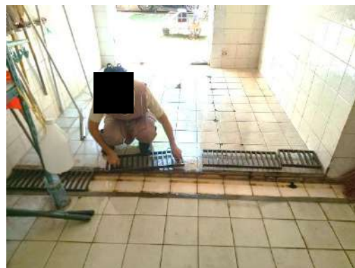
รูปที่ 2-18 รางระบายน้ำห้องรวบรวมขยะและทำความสะอาดรางระบายน้ำห้องรวบรวมมูลฝอย
