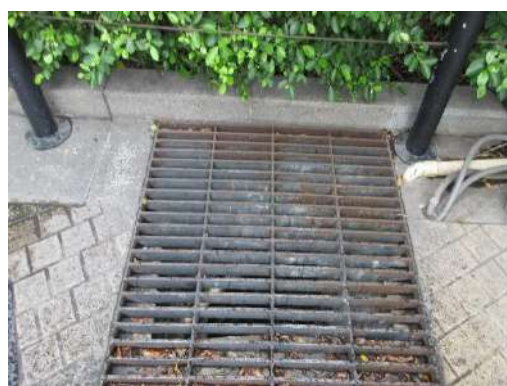
รูปที่ 2-23 ตะแกรงดักขยะ
