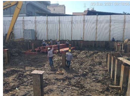
ภาพที่ 5 Sheet Pile
