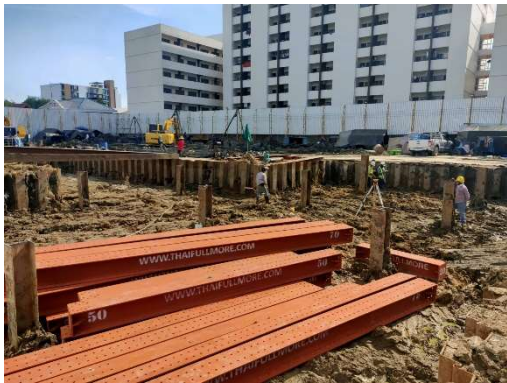
ภาพที่ 5 Sheet Pile
