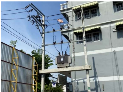
ภาพที่ 34 หม้อแปลงไฟฟ้า และอุปกรณ์ไฟฟ้า
