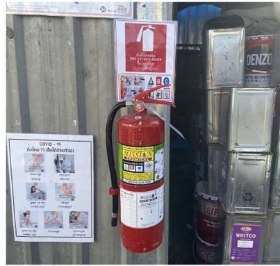
ภาพที่ 37 ถังดับเพลิงเคมีและป้ายแนะนำการใช้งาน
