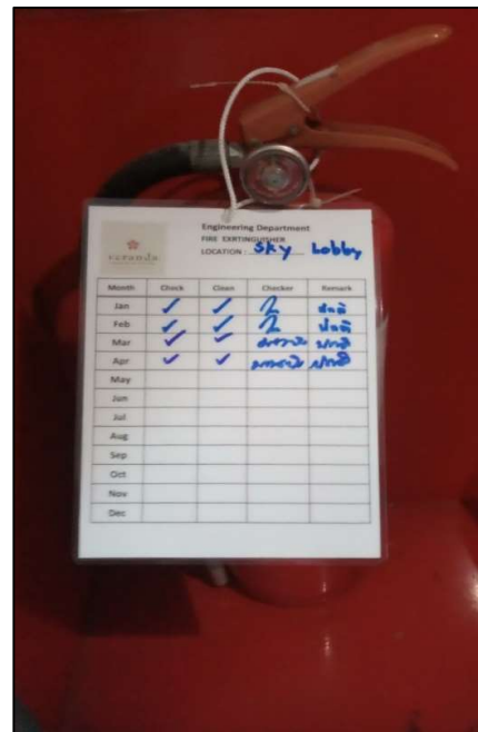
ภาพที่ 30 แสดงถังดับเพลิง - ตรวจสอบประจำเดือน
