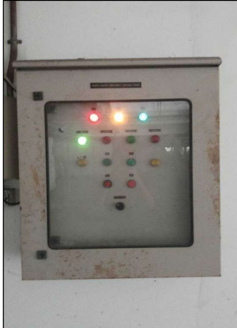
ภาพที่ 49 แสดงตู้คอนโทรลควบคุมการทำงานของเครื่องดีเซล
