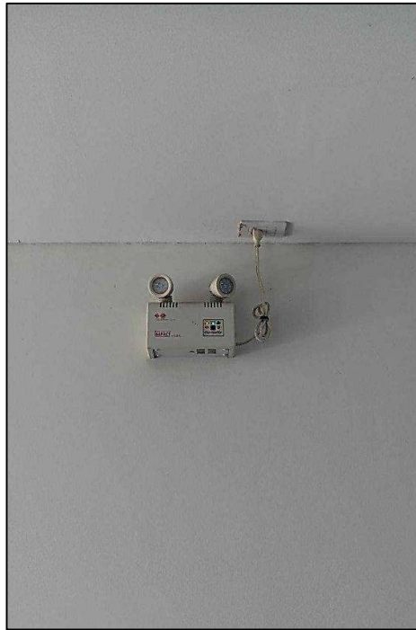
ภาพที่ 29 แสดงไฟส่องสว่างฉุกเฉิน
