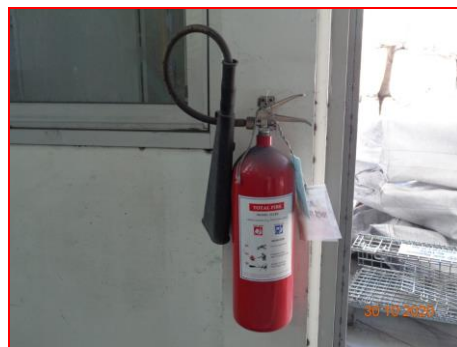
ภาพที่ 2.2-33 ถังดับเพลิงชนิด CO 2 บริเวณภายในอาคารบดตะกั่ว
