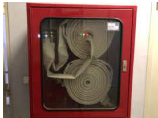
รูปที่ 2-24 ตู้เก็บสายดับเพลิง
