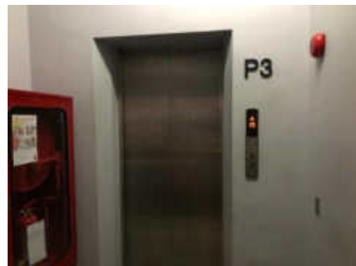
รูปที่ 2-26 ลิฟต์ดับเพลิง
