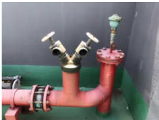
รูปที่ 2-25 หัวรับน้ำดับเพลิงภายนอกอาคาร
