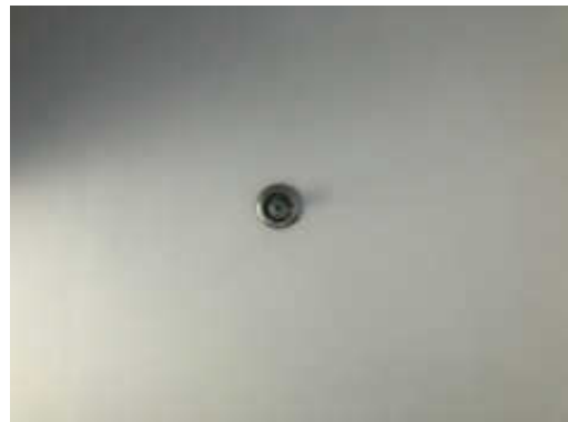
รูปที่ 2-42 หัวกระจายน้ำดับเพลิงอัตโนมัติ
