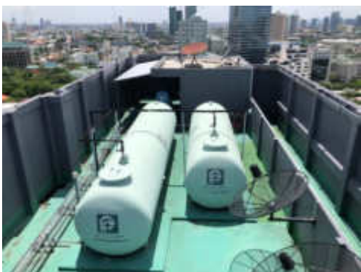
รูปที่ 2-5 ถังสำรองน้ำบนดาดฟ้า
