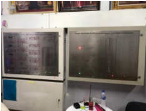
รูปที่ 2-36 แผงควบคุม (Fire Alarm Control Panel)
