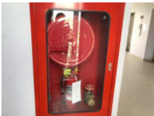
รูปที่ 2-23 ตู้อุปกรณ์ดับเพลิง
