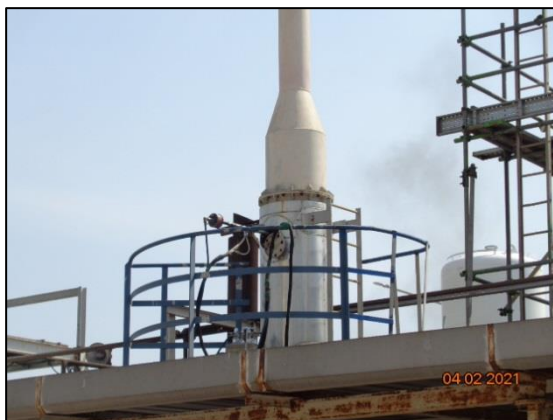
รูปที่ 3.2 การเก็บตัวอย่างคุณภาพอากาศในปล่องระบาย บริเวณ เตาเผาน้ำมันร้อน-ZCT1
