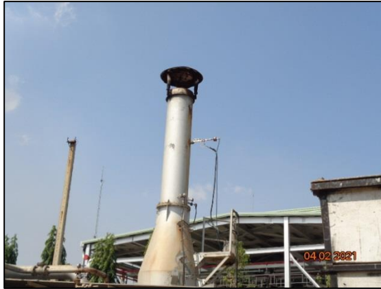
รูปที่ 3.3 การเก็บตัวอย่างคุณภาพอากาศในปล่องระบาย บริเวณ เตาเผาก๊าซจากกระบวนการผลิต-ZCT1
