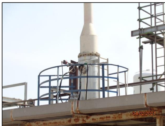
รูปที่ 3.5 การเก็บตัวอย่างคุณภาพอากาศในปล่องระบาย บริเวณ เตาเผาน้ำมันร้อน-ZCT2
