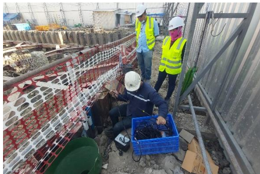
ภาพที่ 15 ติดตั้งอุปกรณ์วัดการเคลื่อนตัวของดิน
