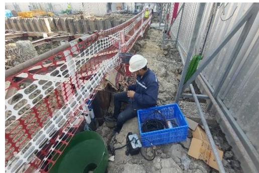
ภาพที่ 15 ติดตั้งอุปกรณ์วัดการเคลื่อนตัวของดิน
