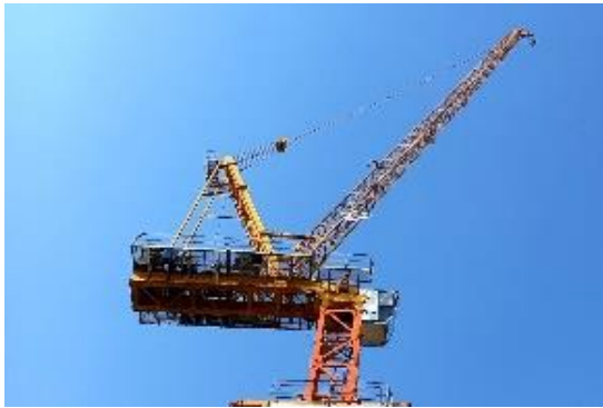
ภาพที่ 52 แขนของเครน (Boom) อยู่ภายในพื้นที่โครงการ
