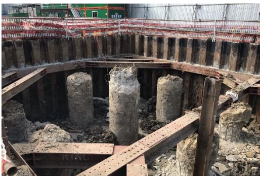
ภาพที่ 14 เสาค้ำเข็มเจาะ
