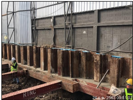
ภาพที่ 13 Sheet Pile และค้ำยัน
