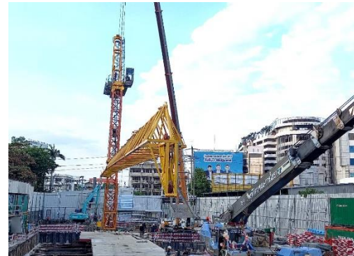
ภาพที่ 52 แขนของเครน (Boom) อยู่ภายในพื้นที่โครงการ
