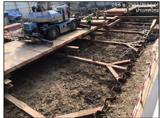
ภาพที่ 13 Sheet Pile และค้ำยัน
