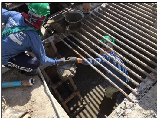
ภาพที่ 30 ขุดลอกตะกอนดินในบ่อพักน้ำ
