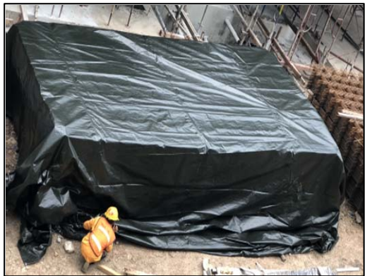
ภาพที่ 7 พื้นที่กองเก็บวัสดุก่อสร้างพร้อมผ้าใบปิดคลุม
