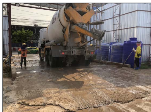
ภาพที่ 11 คนงานฉีดล้างทำความสะอาดล้อรถบรรทุก
