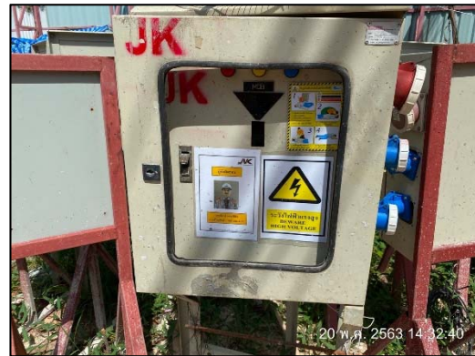
ภาพที่ 37 อุปกรณ์จ่ายไฟฟ้าที่ถูกต้องตามมาตรฐาน
