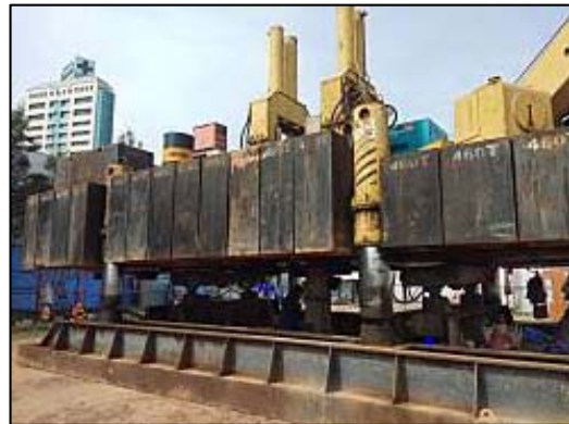
ภาพที่ 30 เสวเข็มแบบกด
