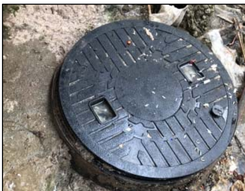
ภาพที่ 34 ถังบำบัดน้ำเสียสำเร็จรูป
