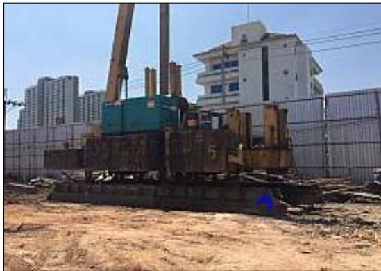
ภาพที่ 30 เสวเข็มแบบกด
