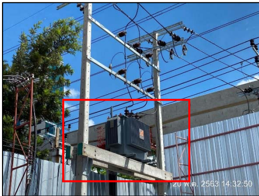
ภาพที่ 37 อุปกรณ์จ่ายไฟฟ้าที่ถูกต้องตามมาตรฐาน
