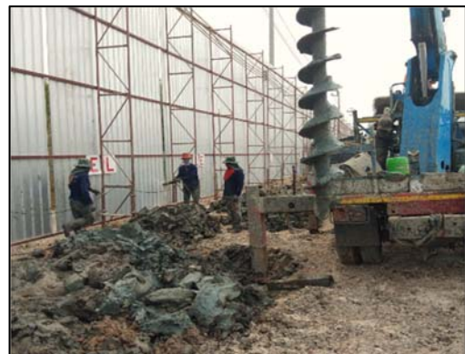
ภาพที่ 31 Sheet Pile/Prebore
