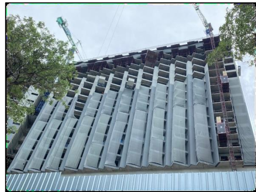
ภาพที่ 16 ติดตั้งผ้าใบ Mesh Sheet รอบตัวอาคาร
