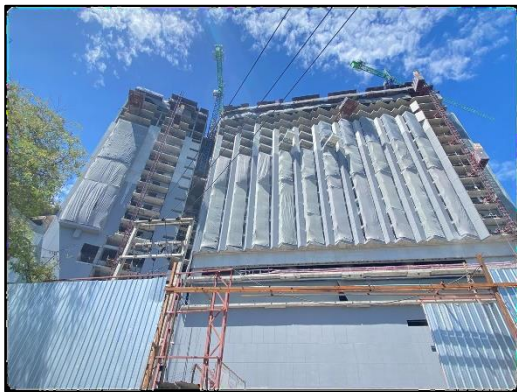
ภาพที่ 16 ติดตั้งผ้าใบ Mesh Sheet รอบตัวอาคาร
