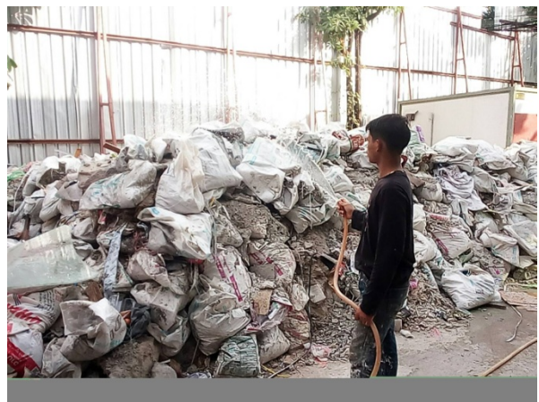
ภาพที่ 6-18 ชีตพรมน้ำบริเวณกองเศษวัสดุก่อสร้าง ไม่ให้มีฝุ่นละอองฟุ้งกระจาย
