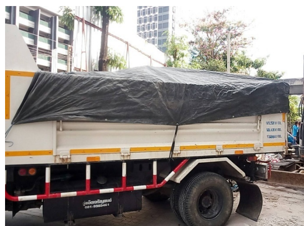
ภาพที่ 6-19 เก็บขนเศษวัสดุก่อสร้างออกนอกพื้นที่โครงการด้วยรถบรรทุก และปิดคลุมท้ายรถอย่างมิดชิดก่อนออกจากโครงการ
