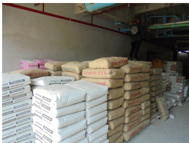
ภาพที่ 6-9 กองถุงวัสดุก่อสร้างไว้ได้อาคารเพื่อป้องกันการฟุ้งกระจายไปยังภายนอกโครงการ
