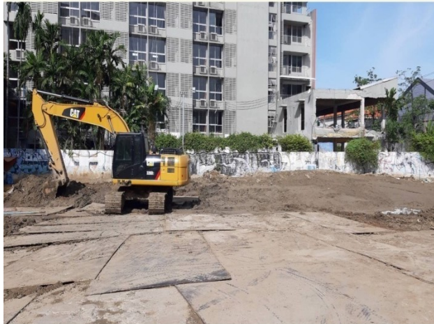
ภาพที่ 6-15 ปูแผ่นเหล็กหนาบริเวณเตรียมพื้นที่ก่อสร้างอาคาร A
