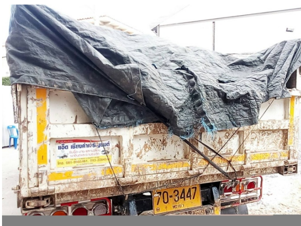
ภาพที่ 6-19 เก็บขนเศษวัสดุก่อสร้างออกนอกพื้นที่โครงการด้วยรถบรรทุก และปิดคลุมท้ายรถอย่างมิดชิดก่อนออกจากโครงการ
