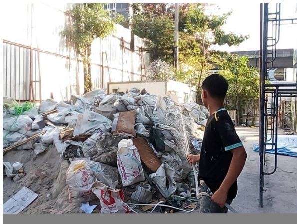
ภาพที่ 6-18 ชีตพรมน้ำบริเวณกองเศษวัสดุก่อสร้าง ไม่ให้มีฝุ่นละอองฟุ้งกระจาย
