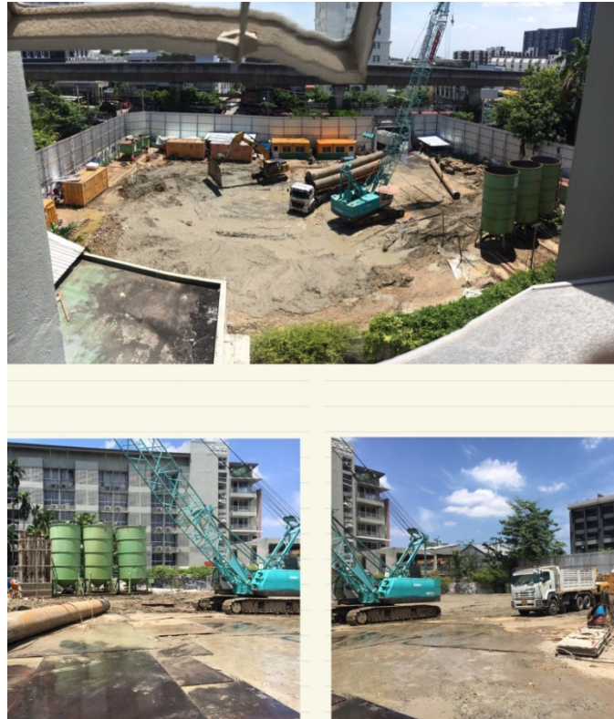
ภาพที่ 6-13 ขนย้ายวัสดุก่อสร้างเข้าพื้นที่ทำเสาเข็มอาคาร A และฉีดล้างล้อรถที่ประตูทางเข้าออกด้านทิศตะวันตกติดกับถนนสุขุมวิท
