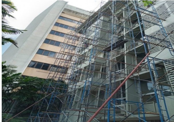
ภาพที่ 6-10 ติดตั้งนั่งร้านที่แข็งแรงไว้ที่อาคาร B
