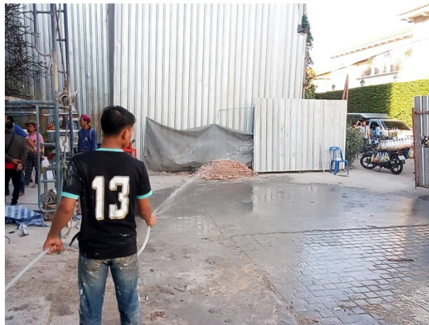
ภาพที่ 6-8 ฉีดพรมน้ำบริเวณพื้นที่โครงการเพื่อลดการฟุ้งกระจายของฝุ่นละออง
