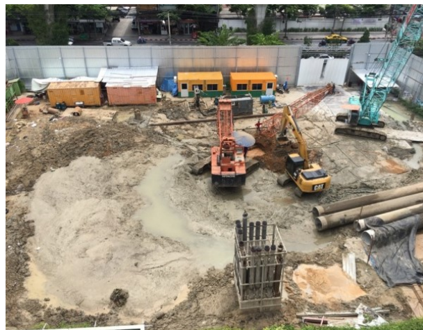
ภาพที่ 6-11 ทำเสาเข็มเจาะภายในโครงการ
