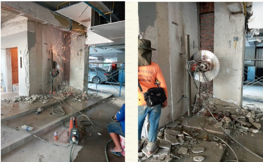
ภาพที่ 6-14 งานตัดผนังลิฟต์ เกิดฝุ่นละอองใช้น้ำฉีดเพื่อลดปริมาณฝุ่นละออง
