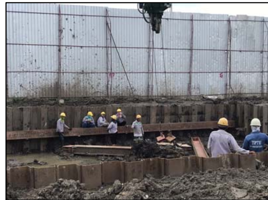
ภาพที่ 3 Sheet Pile
