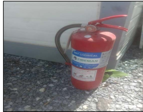
ภาพที่ 21 ถังดับเพลิงเคมี
