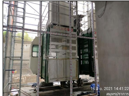
ภาพที่ 59 ลิฟต์ขนส่ง
