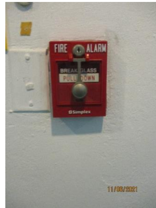
(8) เครื่องแจ้งเหตุโดยใช่มือดึง (Fire Alarm Manual Station)
