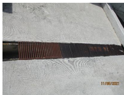
(2) รางระบายน้ำฝนบนดาดฟ้าของอาคาร
