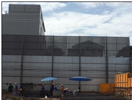
ภาพที่ 2 (ต่อ) รั้ว Metal Sheet รอบพื้นที่โครงการ
