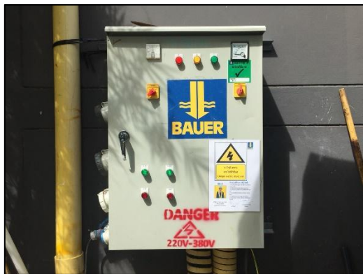
ภาพที่ 22 ตู้ไฟฟ้าชั่วคราว พร้อมติดป้ายเตือนความเสี่ยง
