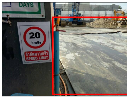
ภาพที่ 28 ปูแผ่นเหล็กบริเวณที่มีรถวิ่งผ่าน
