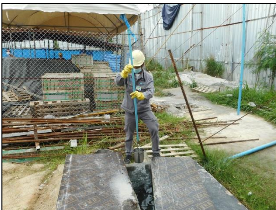
รูปที่ 3.6 การเก็บตัวอย่างคุณภาพน้ำทิ้ง บริเวณ ระบบบำบัดน้ำเสียโครงการ
