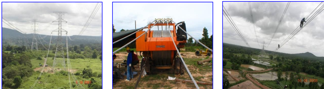
ขั้นตอนที่ 6 งานชิงสายไฟฟ้า และตรวจสอบสายส่งไฟฟ้าก่อนจ่ายไฟ
