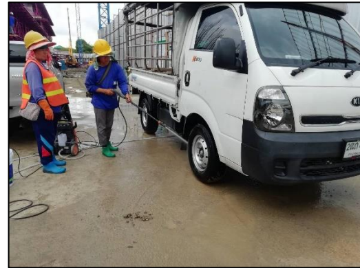
ภาพที่ 9 กิจกรรมทำความสะอาดล้อรถบรรทุก
