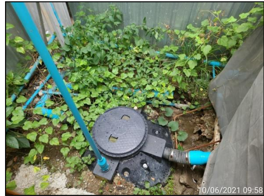
ภาพที่ 31 ระบบบำบัดน้ำเสียสำเร็จรูป
