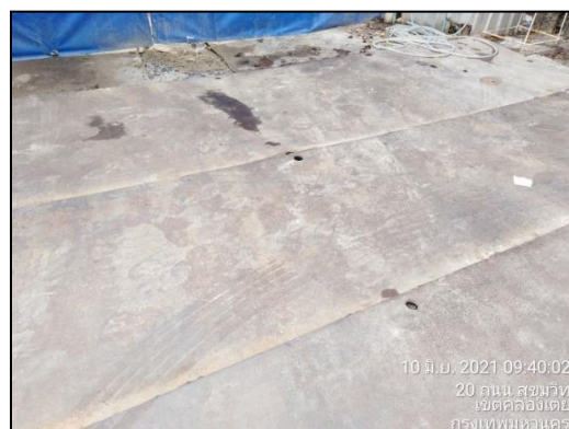
ภาพที่ 23 ปูแผ่นเหล็ก
