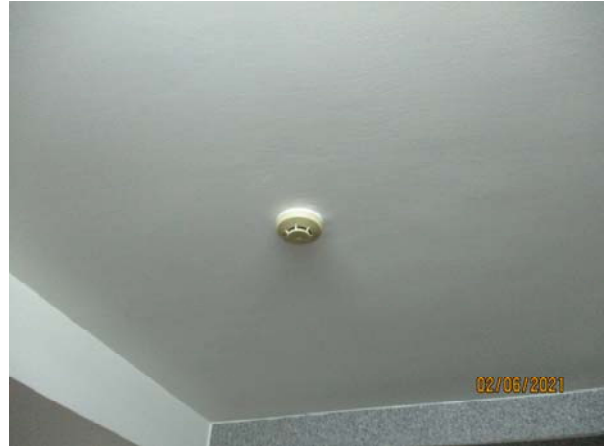
อุปกรณ์ตรวจจับควันไฟ (Smoke Detector)
