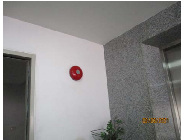
กริ่งสัญญาณเตือนภัย (Fire Alarm Bell)
