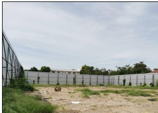
ภาพที่ 1 รั้ว Metal Sheet สูง 6 เมตร โดยรอบพื้นที่ก่อสร้าง
