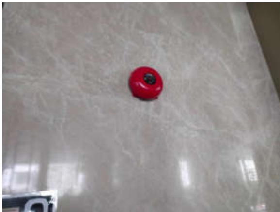
รูปที่ 2-30 กริ่งสัญญาณเตือนภัย (Alarm Bell)
