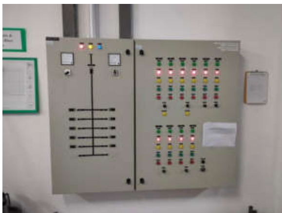
รูปที่ 2-9 ระบบมิเตอร์ไฟฟ้าสำหรับระบบบำบัดน้ำเสีย
