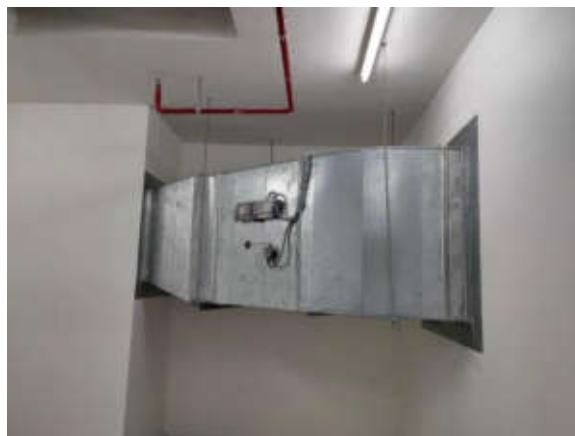
รูปที่ 2-56 ห้องอัดพัฒนาระบายอากาศ
