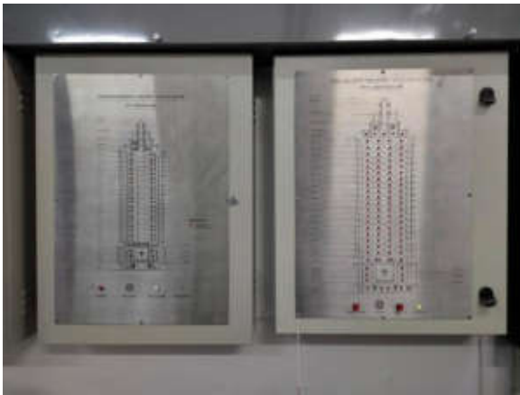
รูปที่ 2-27 แผงควบคุม (Fire Alarm Control Panel)
