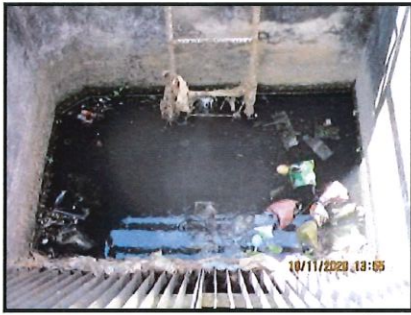
บ่อสูบน้ำก่อนเข้าระบบบำบัดน้ำเสีย โซนที่ 2
