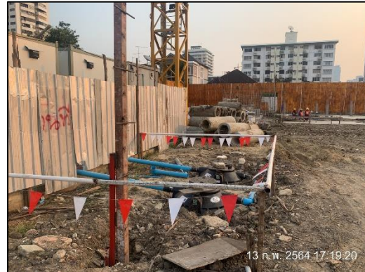
ภาพที่ 15 ระบบบำบัดน้ำเสียสำเร็จรูป
