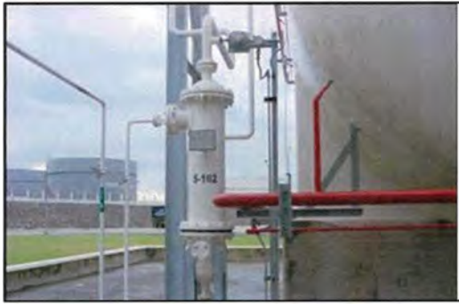
ภาพที่ 2.2-1 Water Scrubber บริเวณถังเก็บ Propylene Oxide
