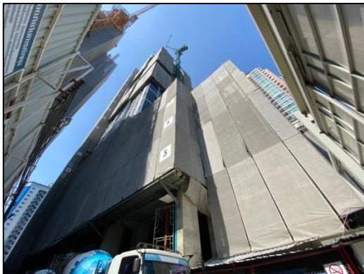
ภาพที่ 56 ติดตั้งผ้าใบก่อสร้าง (Mesh sheet) โดยรอบอาคาร
