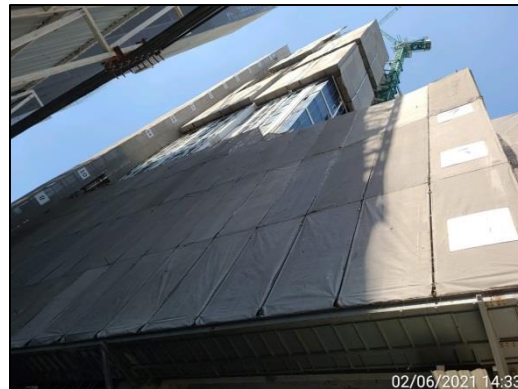
ภาพที่ 56 ติดตั้งผ้าใบก่อสร้าง (Mesh sheet) โดยรอบอาคาร
