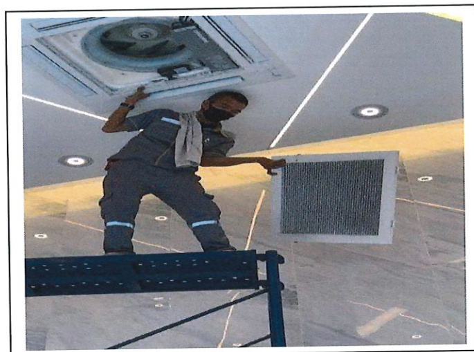
รูปที่ 3-2 ภาพล้างเครื่องปรับอากาศประจำเดือน
