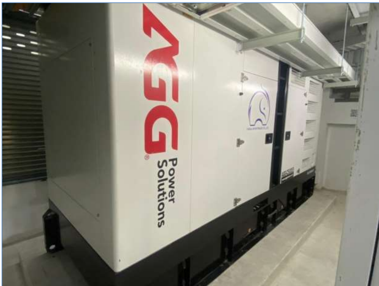
ภาพที่ 3-8(8.2) ช่างอาคารตรวจเช็ค ห้อง Generator เครื่องสำรองไฟฟ้า ทุกวัน และ test run ระบบทุกวันพฤหัสบดี ประมาณ 15 นาที
