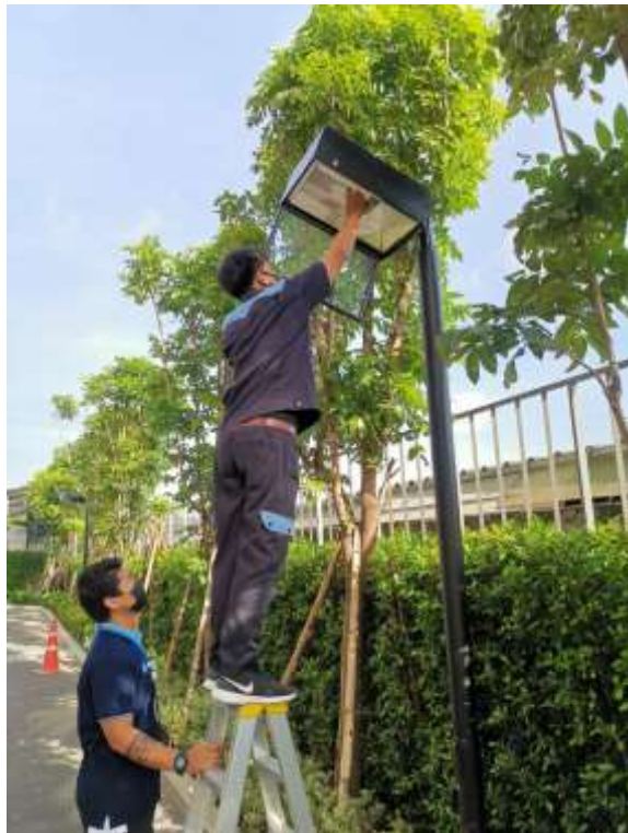
ภาพที่ 3-13(13.2) ทุกวัน ช่างอาคารตรวจสอบไฟแสงสว่างให้เพียงพอและพร้อมใช้งาน
