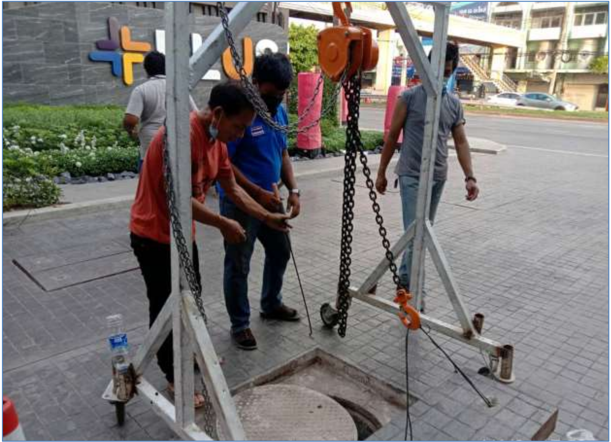
ภาพที่ 3-2(2.1) ช่างอาคารตรวจสอบท่อพักน้ำเดือนละ 1 ครั้ง ถ้ามีตะกอนให้สูบล้างทิ้ง (ต่อ)
