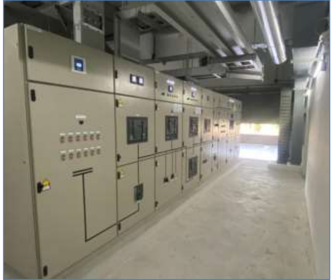
ภาพที่ 3-8(8.2) ช่างอาคารตรวจเช็ค ห้อง MDB ทุกวัน และ test run ระบบทุกวันพฤหัสบดี ประมาณ 15 นาที
