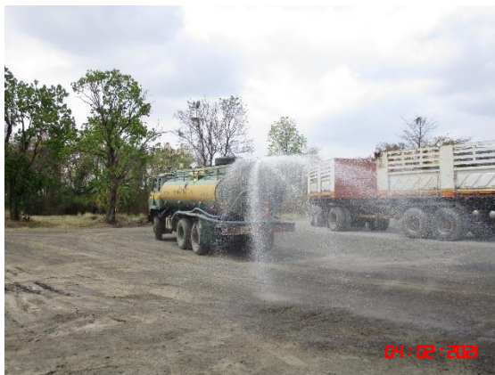
รูปที่ 2-12 การฉีดพรมน้ำเพื่อลดการฟุ้งกระจายของฝุ่นละออง
