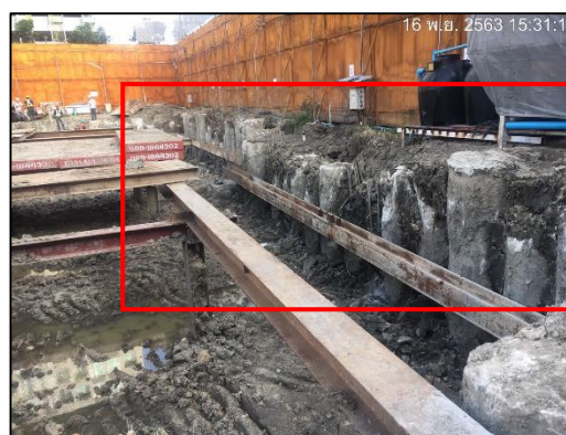
ภาพที่ 37 ผนังกันดินแบบ Pile Wall
