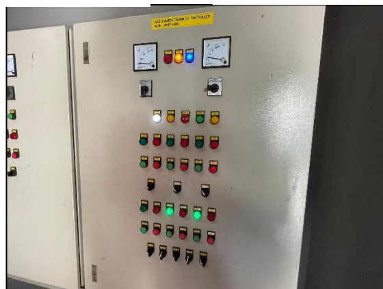
รูปที่ 1-10 ตู้ควบคุมระบบบำบัดน้ำเสีย
