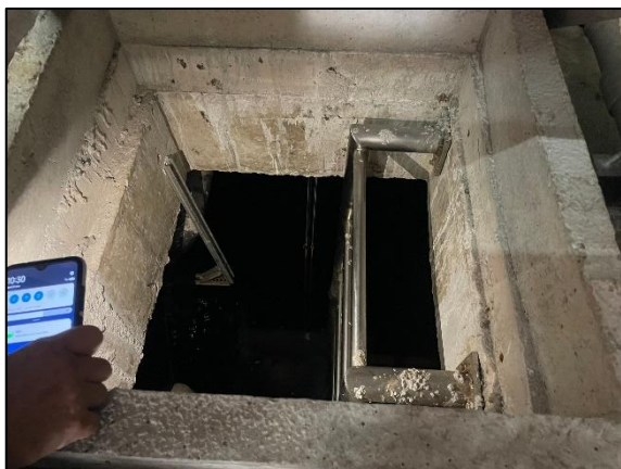
รูปที่ 1-5 ถังเก็บน้ำใต้ดิน
