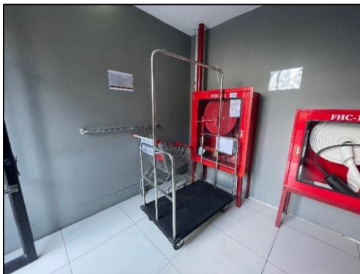
รูปที่ 1-28 ตู้หัวฉีดน้ำดับเพลิงและถังดับเพลิง เคมีภายในอาคาร
