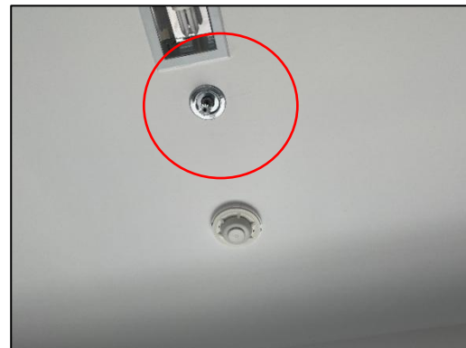
รูปที่ 1-29 Sprinkler
