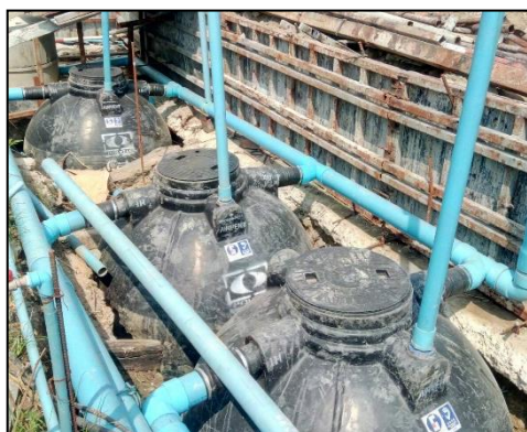
ภาพที่ 17 ถังบำบัดน้ำเสียสำเร็จรูป
