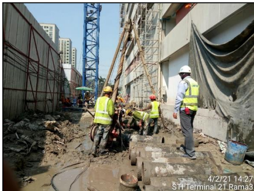
ภาพที่ 14 เสาค้ำเจาะ
