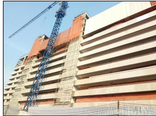
ภาพที่ 10 Mesh Sheet ปิดคลุมโดยรอบอาคาร
