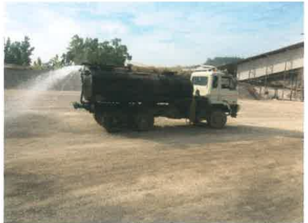
รูปที่ 12 ฉีดพรมน้ำตามเส้นทางลำเลียงแร่ภายในโรงไม้หิน
