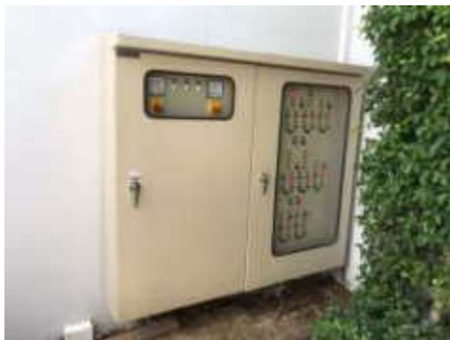
รูปที่ 2-37 มิเตอร์ไฟของระบบบำบัดน้ำเสีย
