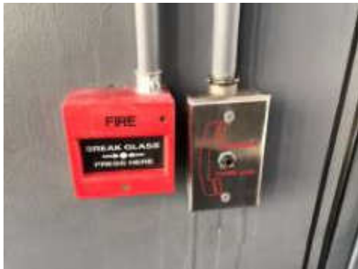
รูปที่ 2-8 อุปกรณ์แจ้งเหตุด้วยมือ และชุดเต้าเสียบโทรศัพท์
