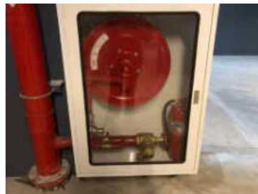
รูปที่ 2-13 ตู้เก็บอุปกรณ์ดับเพลิง
