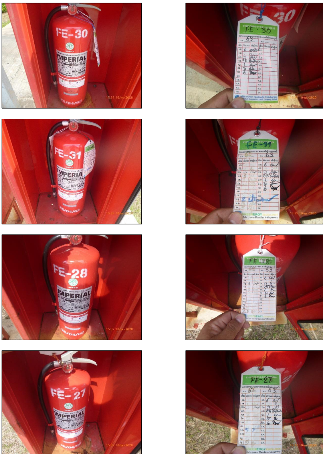
รูปที่ 3-9 การตรวจเช็คอุปกรณ์ดับเพลิงแบบมือถือ บริเวณหน้าท่าเทียบเรือ
