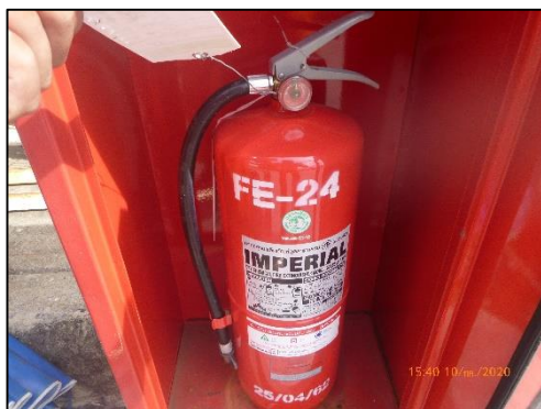
รูปที่ 3-9 (ต่อ) การตรวจเช็คอุปกรณ์ดับเพลิงแบบมือถือ บริเวณหน้าท่าเทียบเรือ
