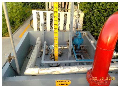
Slop Tank ที่อยู่ใต้ดิน
