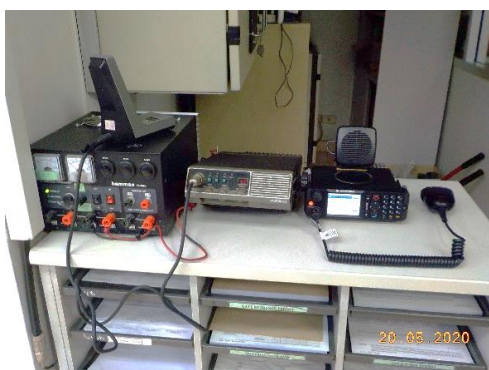
รูปที่ 2-14 เครื่องมือติดต่อสื่อสารระหว่างเรือและท่าเรือ
