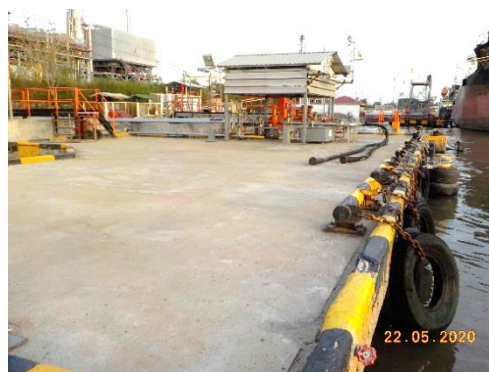
รูปที่ 2-2 คัน Curb บริเวณขอบ Platform ของท่าเทียบเรือ
