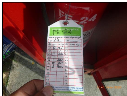
รูปที่ 3-9 (ต่อ) การตรวจเช็คอุปกรณ์ดับเพลิงแบบมือถือ บริเวณหน้าท่าเทียบเรือ
