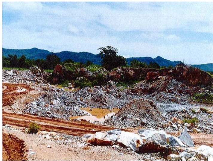
รูปที่ 12 แสดงคันทำนบดิน โดยที่ใช้โซดของหินปรับแต่งเป็นแนวคันทำนบ บริเวณด้านตะวันออกทางเข้าโครงการฯ
