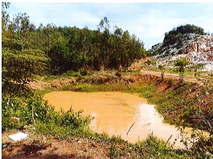
รูปที่ 13 แสดงบ่อดักตะกอน รองรับน้ำฝนที่ไหลผ่านพื้นที่ทำเหมือง
