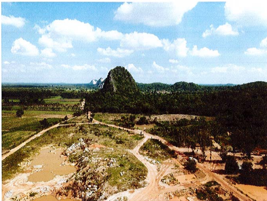
รูปที่ 9 แสดงสภาพพื้นที่หน้าเหมืองบริเวณด้านทิศตะวันออกของประทานบัตร มีการทำเหมืองเป็นแบบขั้นบันได
