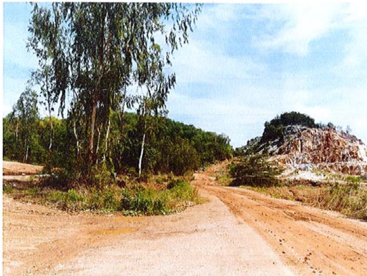
รูปที่ 10 แสดงถนนในโครงการฯ เป็นถนนดินลูกรังอัดแน่น
