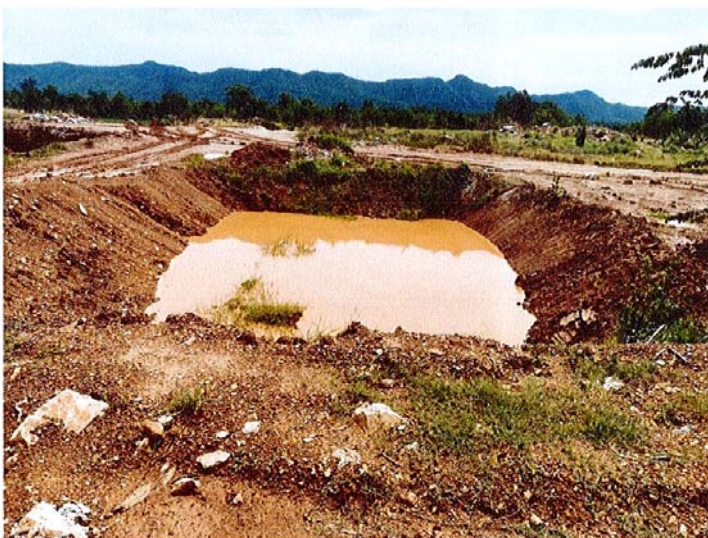
รูปที่ 14 แสดงบ่อดักตะกอน รองรับน้ำฝนที่ไหลผ่านพื้นที่ทำเหมืองด้านทิศใต้ของพื้นที่โครงการฯ
