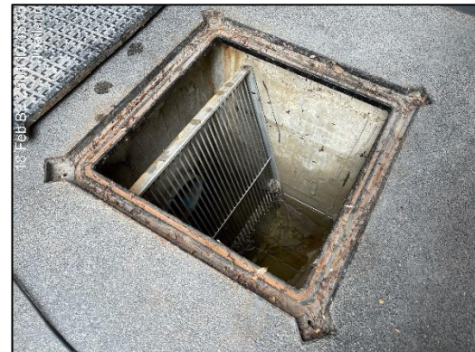
ภาพที่ 7 ตระแกรงดักขยะบริเวณบ่อพักน้ำ
