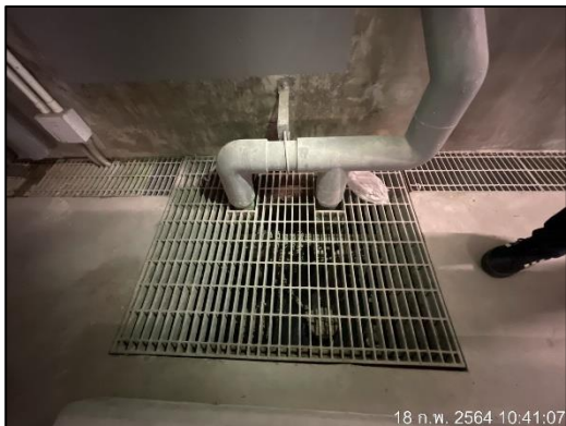
ภาพที่ 24 ตระแกรงปิดบริเวณบ่อพักน้ำ
