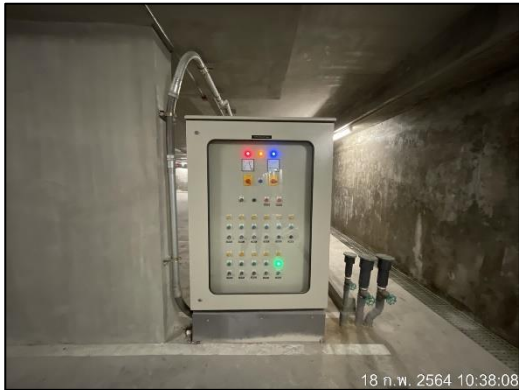
ภาพที่ 28 ตู้ไฟฟ้าระบบบำบัดน้ำเสีย
