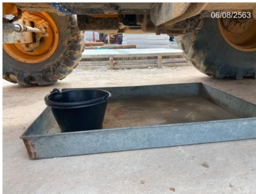
รูปที่ 3-59 ถาดสำหรับรองรับน้ำมันที่จะหกรั่วไหล
