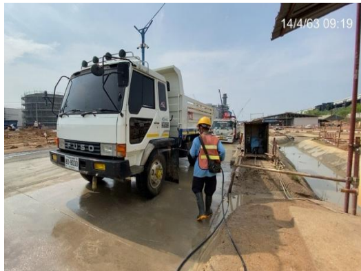
รูปที่ 3-7 การทำความสะอาดล้อรถก่อนออกจากพื้นที่โครงการ
