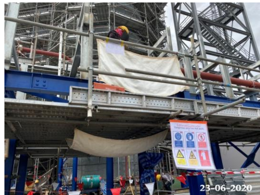
รูปที่ 3-60 ฉนวนกันไฟบริเวณเชื่อมโลหะบนที่สูง
