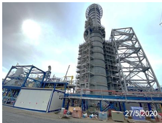
รูปที่ 3-61 ทางเดินและบันไดขึ้นลงของหน่วยผลิตไอน้ำ
