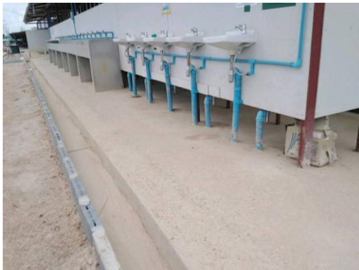
รูปที่ 3-23 ร่องระบายน้ำสำหรับรองรับน้ำเสียจากกิจกรรมก่อสร้าง
