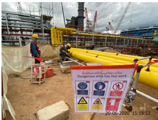
รูปที่ 3-63 ป้ายเตือนอันตรายบริเวณเชื่อมต่อระบบท่อส่งก๊าซธรรมชาติ
