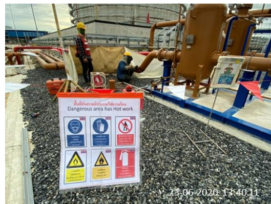
รูปที่ 3-64 ป้ายเตือนอันตรายบริเวณเชื่อมต่อระบบท่อส่งน้ำมันดีเซล
