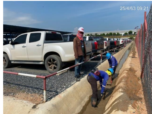
รูปที่ 3-18 การทำความสะอาดรางระบายน้ำ
