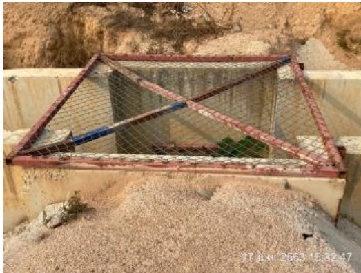
รูปที่ 3-17 จุกระบายน้ำฝนลงสู่รางระบายน้ำฝนของนิคมฯ
