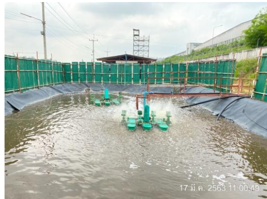
รูปที่ 3-24 บ่อพักน้ำทิ้งสำหรับรองรับน้ำเสียจากกิจกรรมก่อสร้าง
