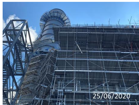
รูปที่ 3-62 การติดตั้งฉนวนกันความร้อนของระบบท่อไอน้ำและน้ำร้อน
