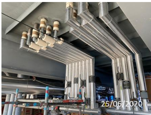
รูปที่ 3-62 การติดตั้งฉนวนกันความร้อนของระบบท่อไอน้ำและน้ำร้อน
