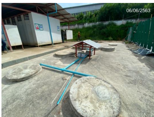
รูปที่ 3-21 ระบบบำบัดน้ำเสียสำเร็จรูป
