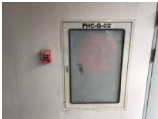
รูปที่ 2-15 ตู้เก็บสายฉีดน้ำดับเพลิงพร้อมอุปกรณ์
