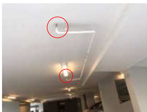
รูปที่ 2-17 ระบบหัวกระจายน้ำดับเพลิงอัตโนมัติ (Sprinkler System)
