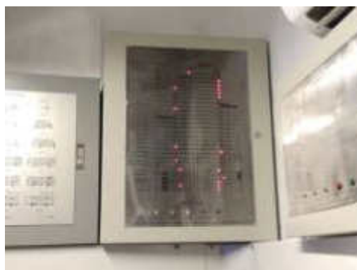
รูปที่ 2-19 แผงควบคุม (Fire Alarm Control Panel : FCP)
