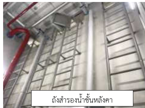
รูปที่ 2-6 (ต่อ) ระบบสูบน้ำในอาคาร และถังสำรองน้ำ
