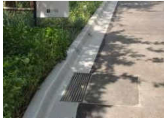
รูปที่ 2-31 ใช้ตะแกรงครอบตามรูท่อระบายน้ำทั้ง ภายในและภายนอกอาคาร
