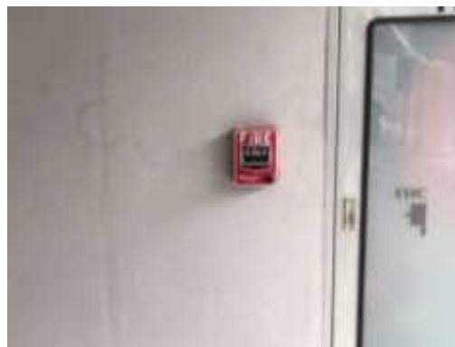
รูปที่ 2-21 เครื่องแจ้งเหตุโดยใช่มือดึง (Manual Station)
