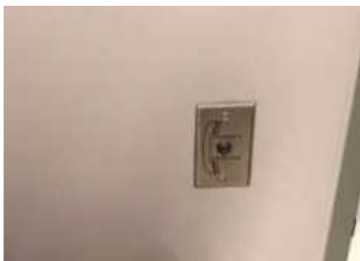
รูปที่ 2-22 ชุดเต้าเสียบโทรศัพท์ (Fire Telephone Outlet)
