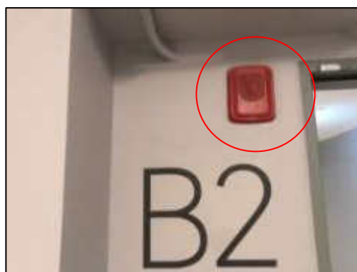
รูปที่ 2-23 ลำโพงแจ้งสัญญาณเตือนอัคคีภัยติดผนัง (Loudspeaker (Wall Mounted))
